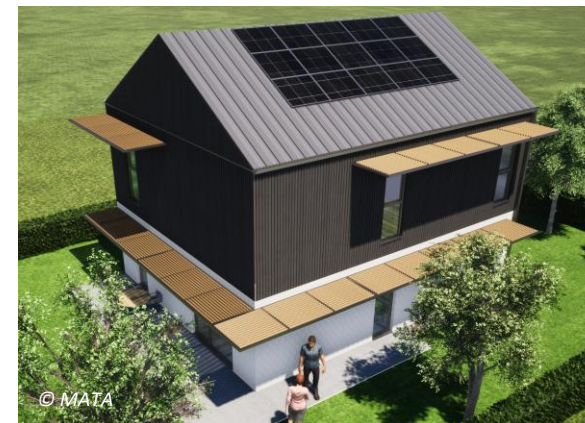
À Bétheny (51), Plurial Novilia réalise, en partenariat avec Inergreen, un projet pilote de construction modulaire biosourcé : 2 maisons en ossature bois et en construction hors-site, conformes à la RE2020 palier 2031.
