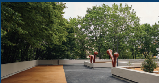
RÉSIDENCE VIVALDI / 59009 VILLENEUVE-D'ASCQ / Réhabilitation de bureaux en une résidence étudiante de 189 logements / livrée en juin 2023
