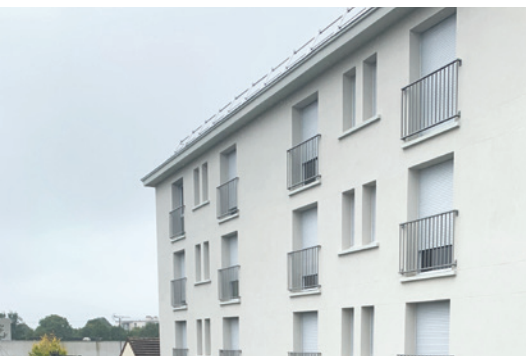
RÉSIDENCE LES ROSES / 77380 COMBS-LA-VILLE / Un ancien foyer pour seniors transformé en résidence sociale / livrée en septembre 2024
